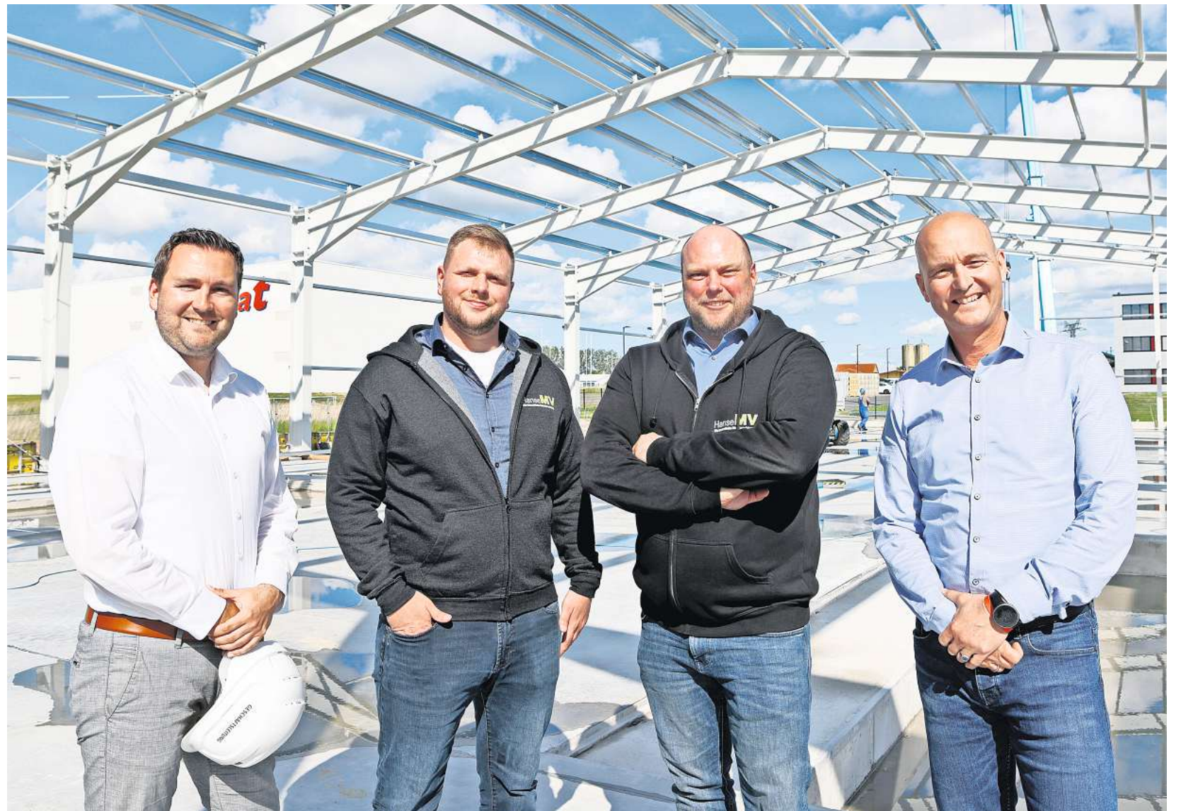
Im Rohbau der neuen Halle stehen die Gesellschafter Stefan Karnatz (v. l.), Artem Melman, Gregor Pollex und Bernd Schröter.
