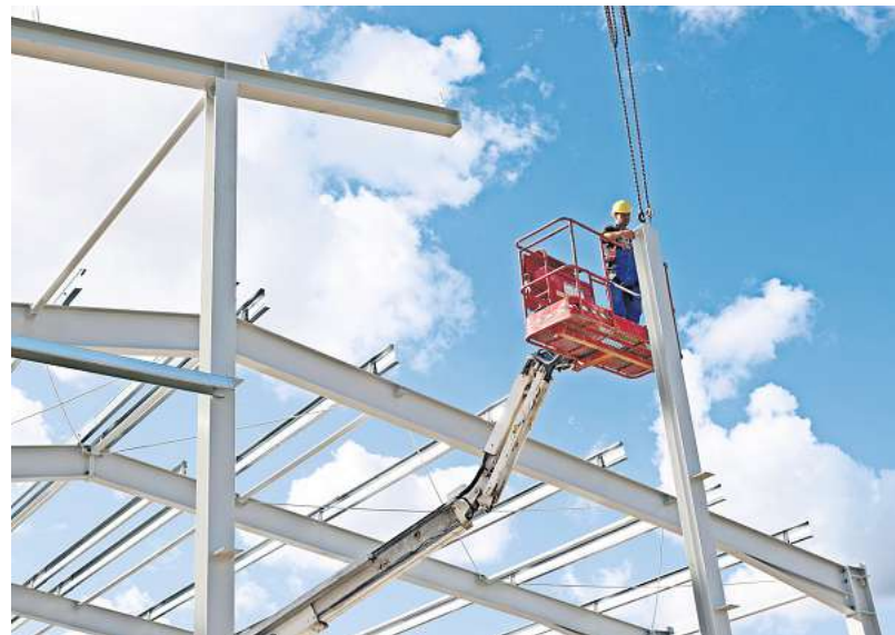
Stahlbauer Michael Kieckhäfer installiert einen Träger.
