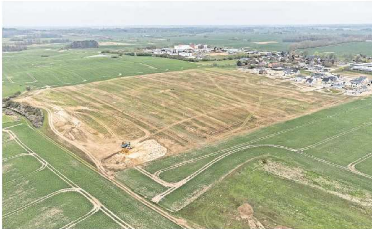
Im neuen Baugebiet „Am Recknitzpark“ in Tessin, das jetzt erschlossen wird, entstehen 168 Wohneinheiten.
