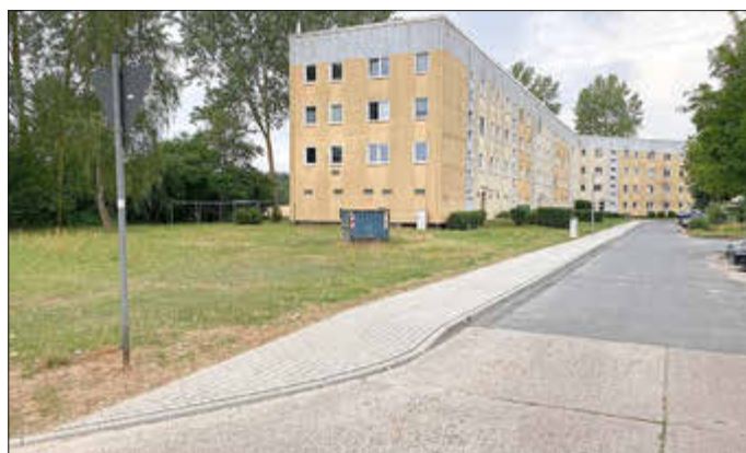
Gehweg nach Fertigstellung
