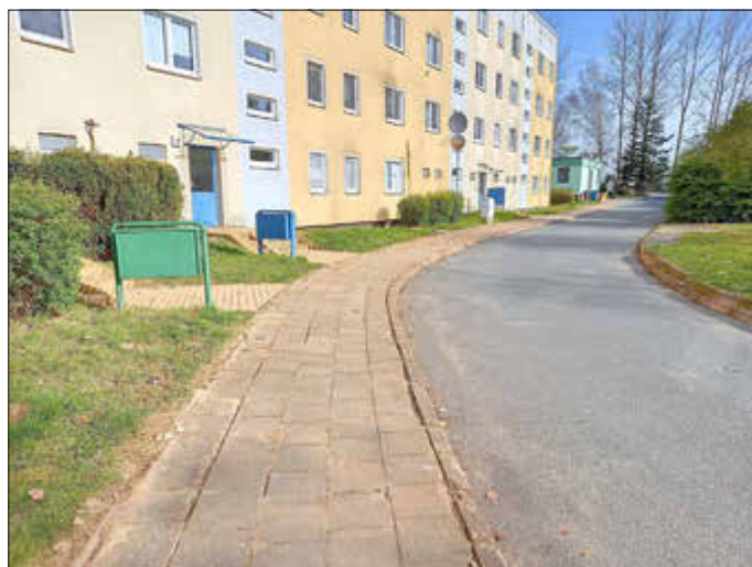
Ausgangssituation vor Baubeginn
