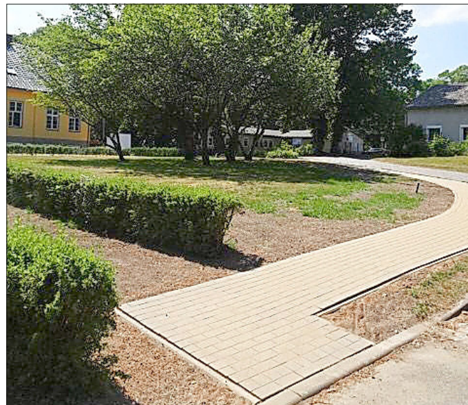
Gehweg Dorfplatz nach Fertigstellung
