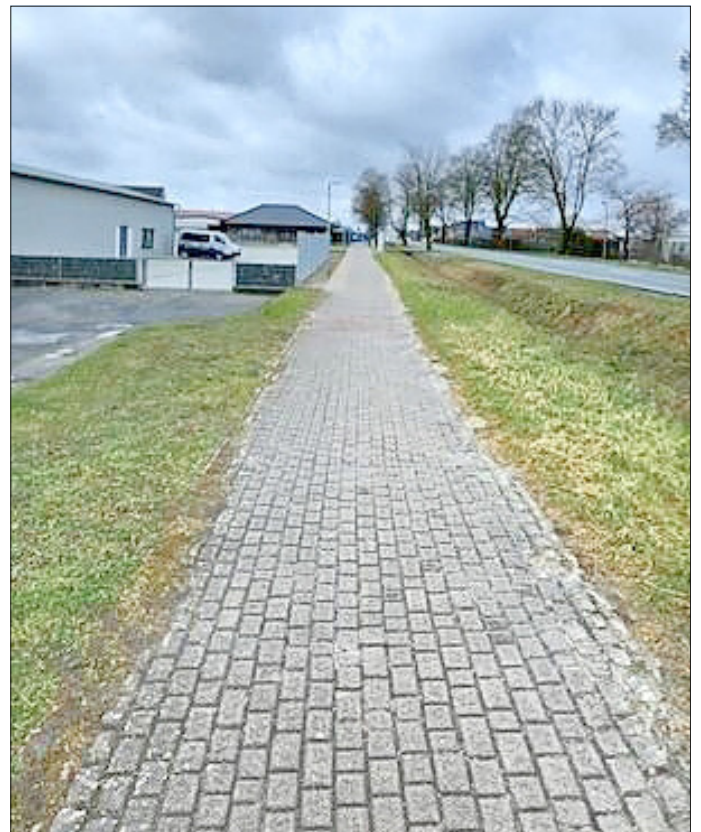
Geh- und Radweg an der B110 südlich der Rostocker Chaussee
